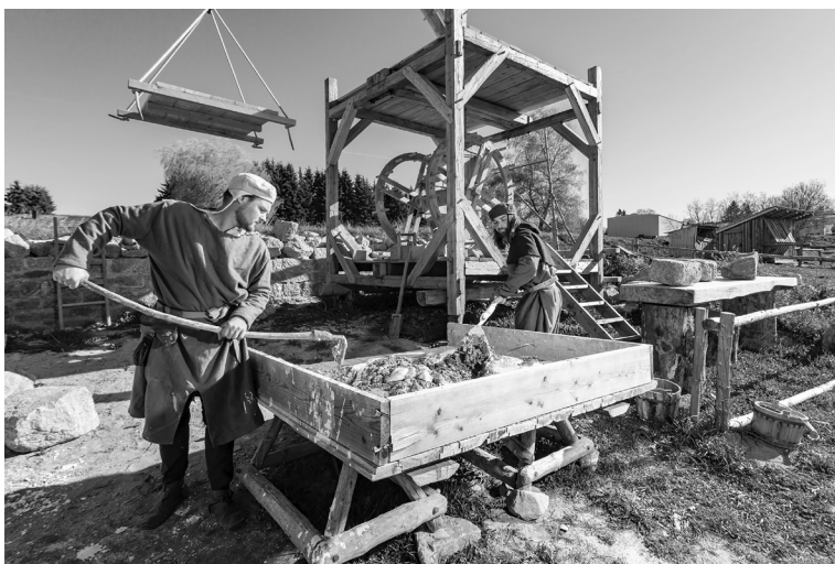
Obr. 3: Příprava malty na staveništi dvorce Karla IV (foto Klaus Schicker; zdroj https://www.schicker-allmedia.de ).
