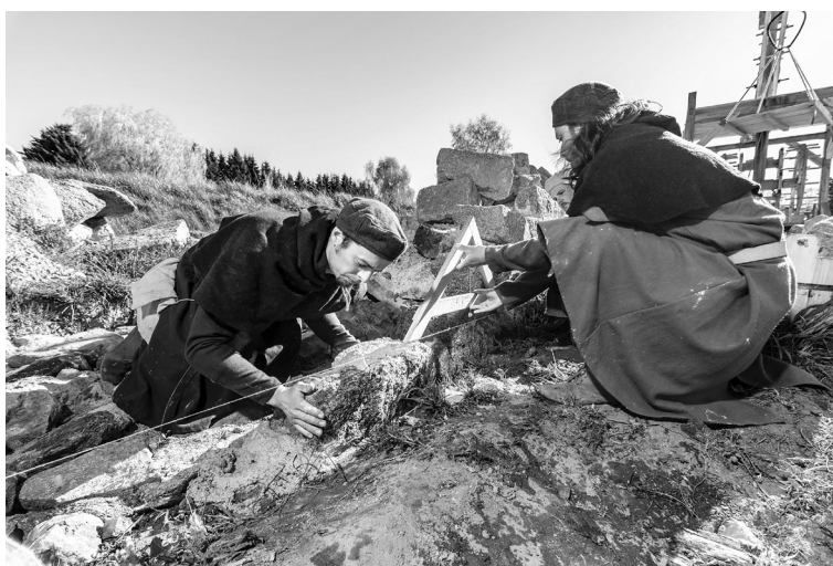
Obr. 4: Stavba zdi dvorce Karla IV. prováděná zkušenými řemeslníky s rozsáhlými znalostmi středověkých technik (foto Klaus Schicker; zdroj https://www.schicker-allmedia.de ).
